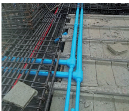
Tuberías empotradas en losa.
